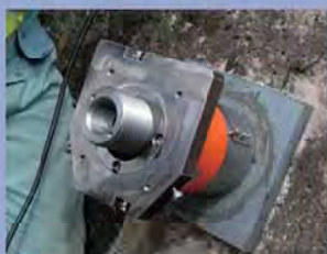
③ 荷重計設置
