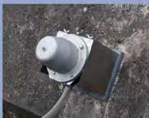
⑧ 設置完了
