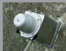
④設置完了
