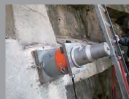
④設置完了
