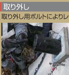
⑥ 取り外し用ボルトの設置
