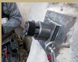
② セッター付きくさびの設置
