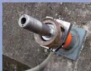
⑤ アタッチメント設置
