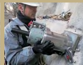
④ SAAMジャッキの設置
