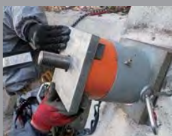
②ロードセル設置
