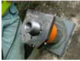
a) 荷重計の設置
