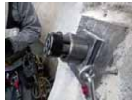
b) くさびの設置
