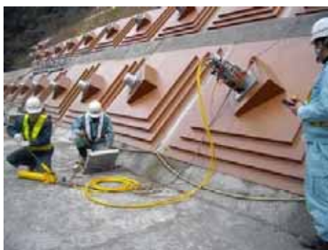
写真-1 SAAM ジャッキによるリフトオフ試験
