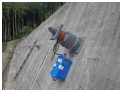
写真-7 荷重計設置状況 (A3-14 アンカー)
