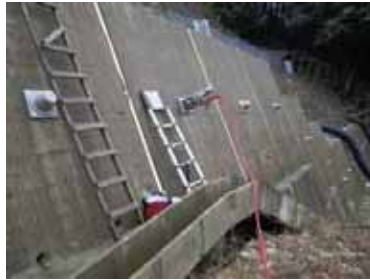
写真-6 リフトオフ試験状況
