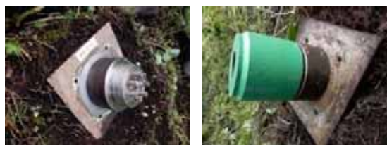
b) くさびナット併用定着タイプ
