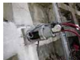
d) SAAM ジャッキの設置
