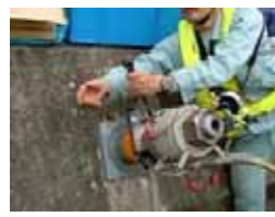
c) 上部止めナットによる定着
