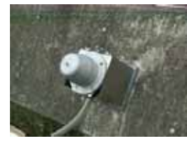
d) 設置完了
